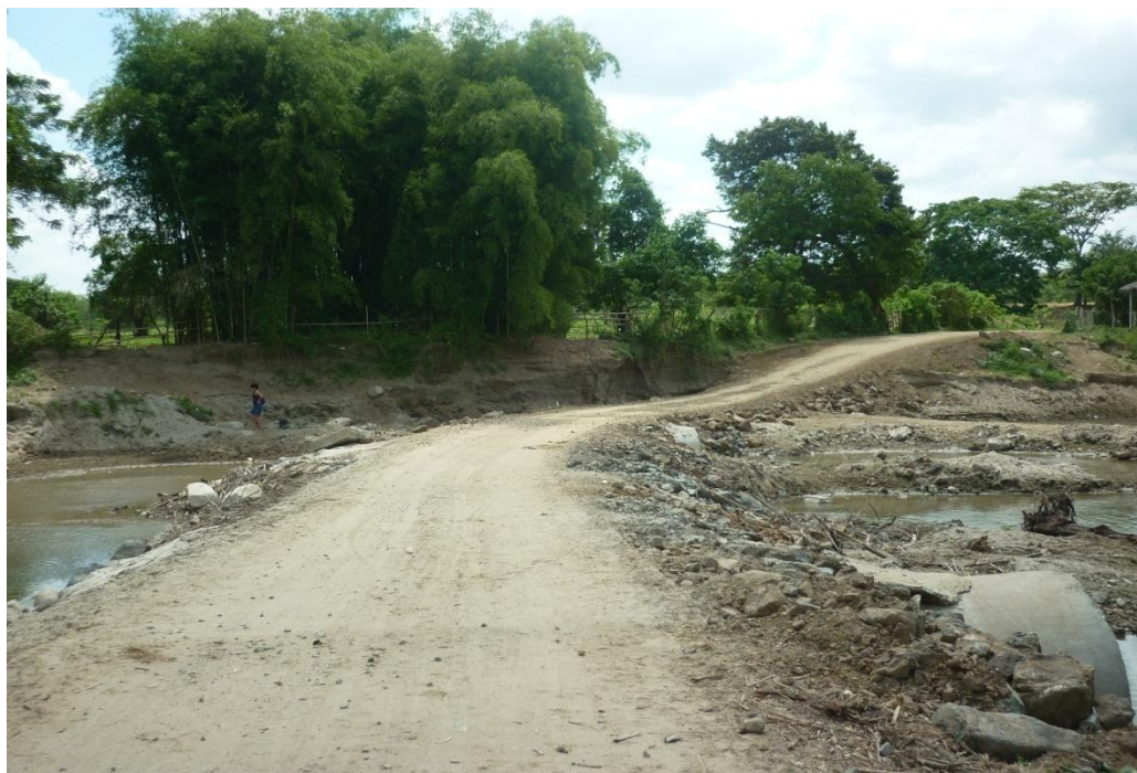
Foto N°5. Paso Peatonal Balneario La Ciénaga
