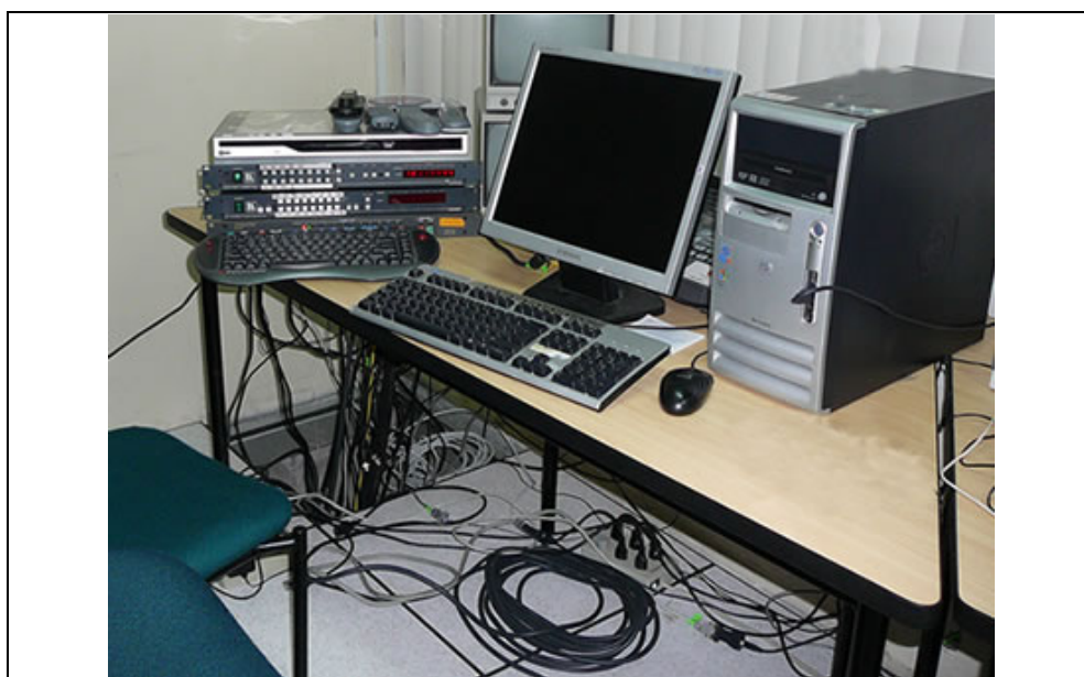
Figura 4.8 Previa a la Adecuación Física
