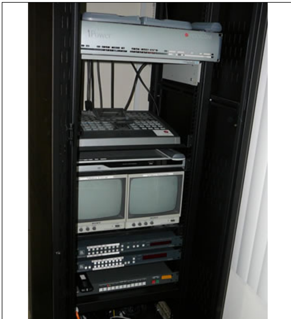
Figura 4.10 Posterior a la Adecuación Física
