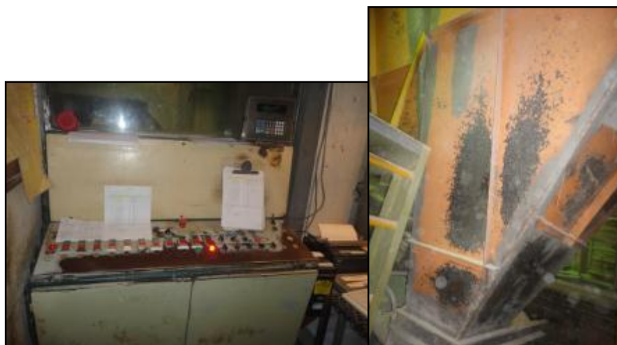
Figura 3.7 Área de Dosificación
