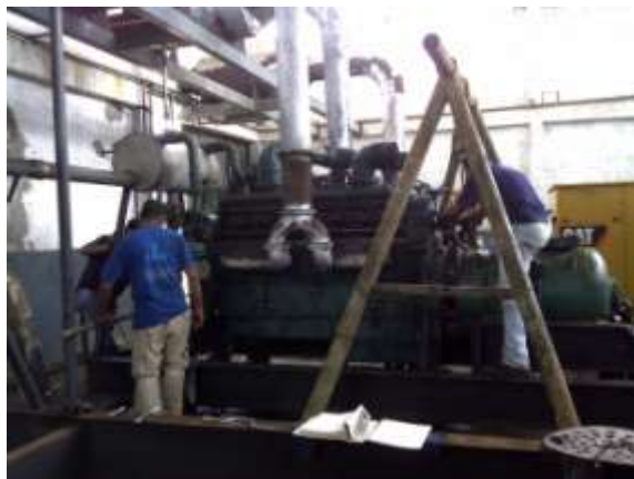
Figura 3.12 Mantenimiento Correctivo Generador.
