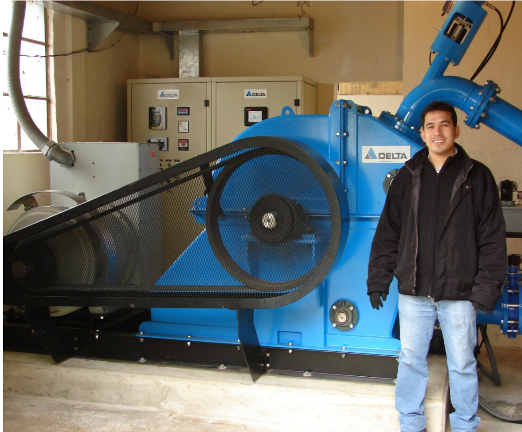
FIGURA 2.14a TURBINA HIDRÁULICA DELTA, PROYECTO OYACACHI 90kW. Cortesía: DELTA Delfini & Cía., S.A.
