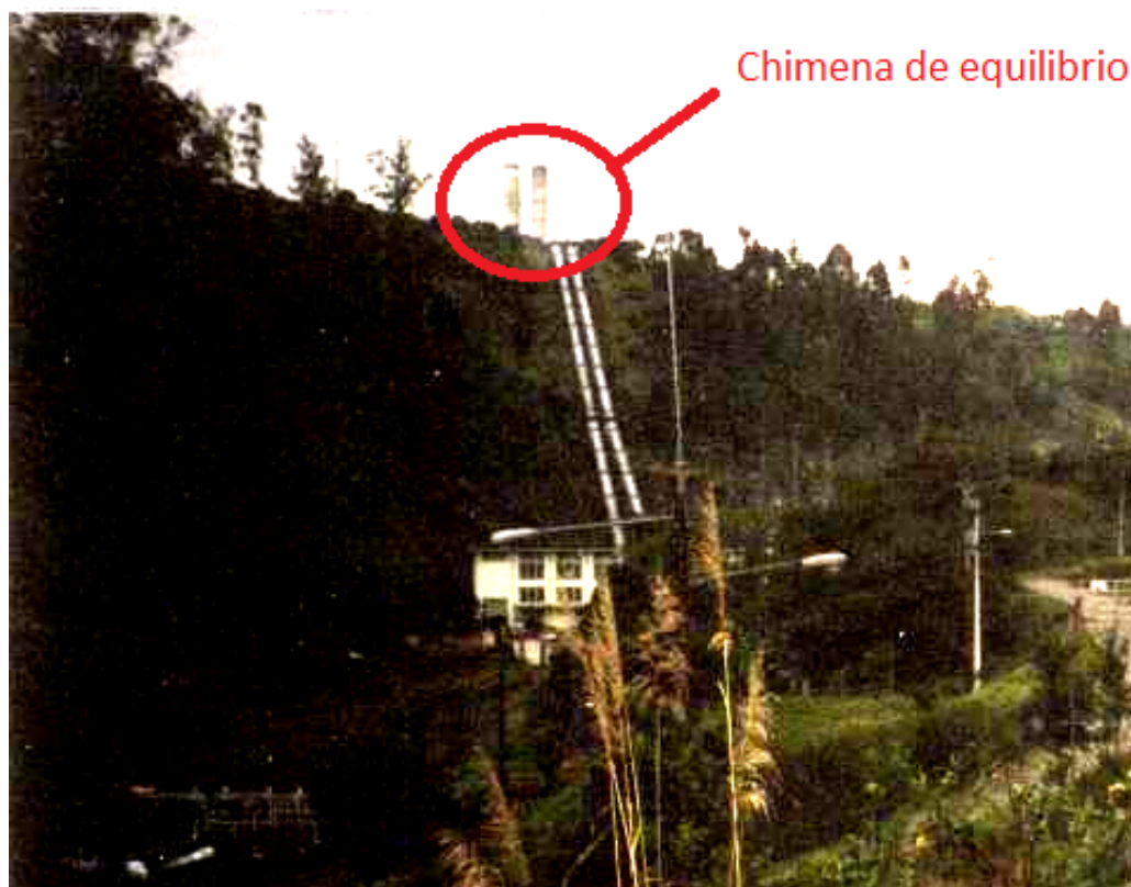
FIGURA 2.22 CHIMENEA DE EQUILIBRIO, CENTRAL HIDROELECTRICA CUMBAYA. Fuente: Informe del Ing. Jorge Arancibia para Salomón Smith Barney.
