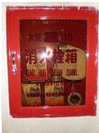
FIGURA 2.12 HIDRANTE INTERIOR
