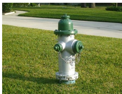
FIGURA 2.11 HIDRANTE EXTERIOR
