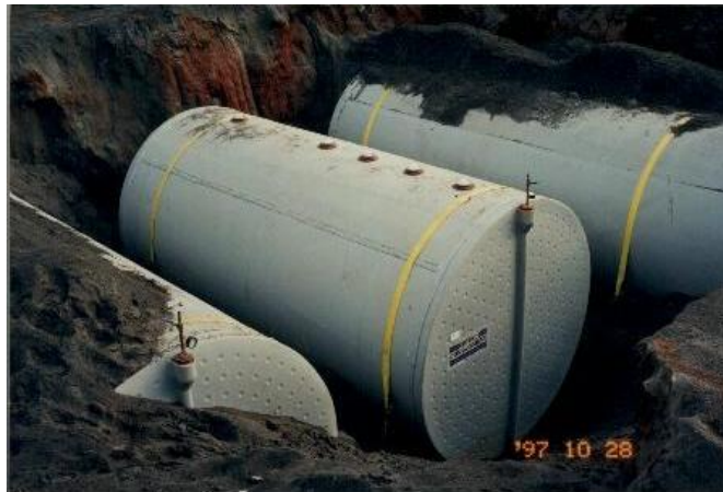
Figura 4.6 Tanques de almacenamiento
