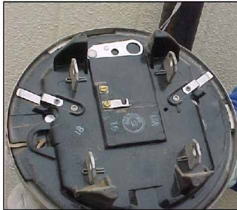
FIGURA 3 – 04: PUENTE DE BOBINA ABIERTO
