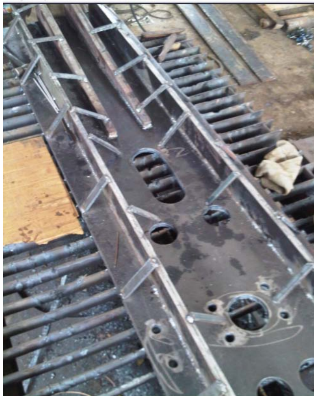
Figura A.12 Soldadura de una de las piezas más grandes del Martillo Excavador
