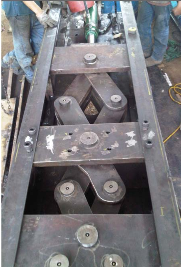
Figura A.20 Prueba del mecanismo accionado por el cilindro hidráulico
