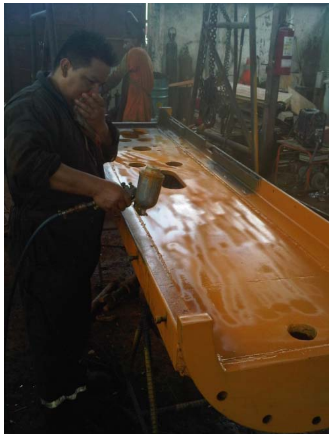
Figura A.21 Aplicación de pintura sobre una de las partes
