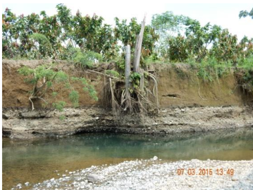
Fotografía 6.- Socavación en el cauce
