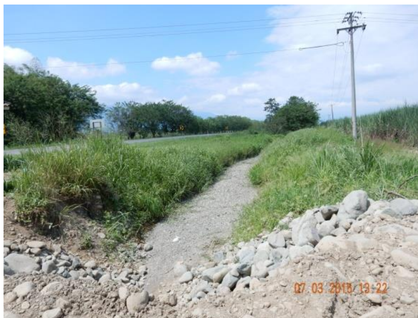
Fotografía 8.-Canales generados por el dique de la carretera Tomado por el autor
