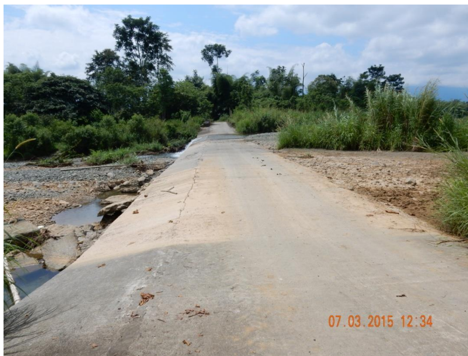
Fotografía 16.- Vista Transversal del Dique Tomado por el autor
