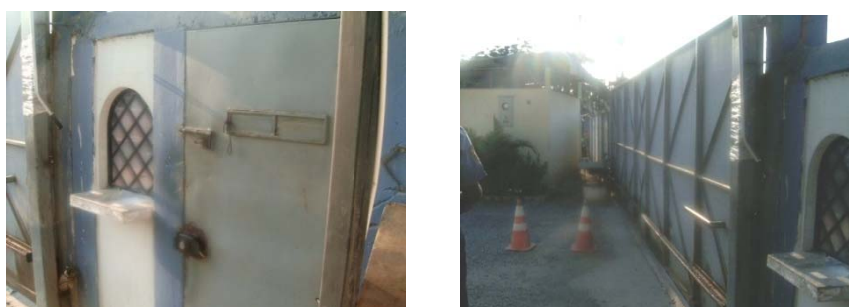
FIGURA 3.10 A) IZQUIERDA. PUERTA DE INGRESO PEATONAL B) DERECHA. INGRESO VEHICULAR
