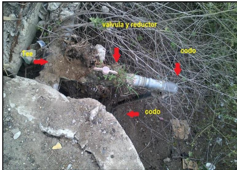
**Figura 4.5 Tipo de instalación de la red de la JAPRM**
