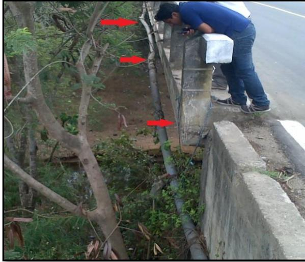
**Figura 4.6 Incorrecta instalación de la tubería en el puente**
