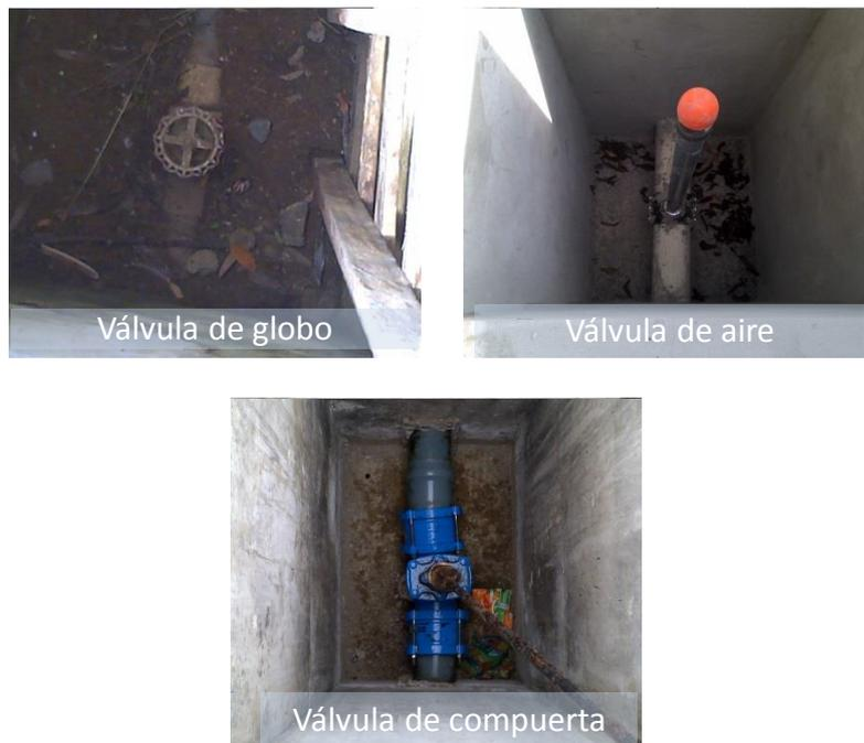
**Figura 3.5 Tipos de válvula de la red (JAPRM)**
