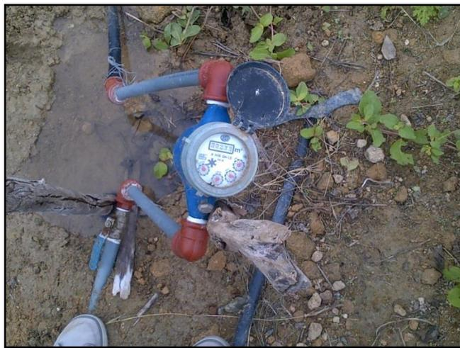
**Figura 3.6 Medidor de una conexión domiciliaria (JAPRM)**
