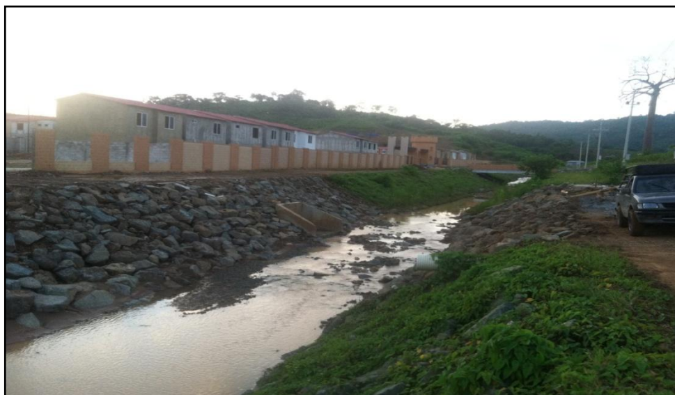
Foto 4.1.- Canal de tierra para evacuación de aguas lluvia perteneciente a la 2da etapa de la urbanización “La Joya”. Fuente: Autores, Junio 2015
