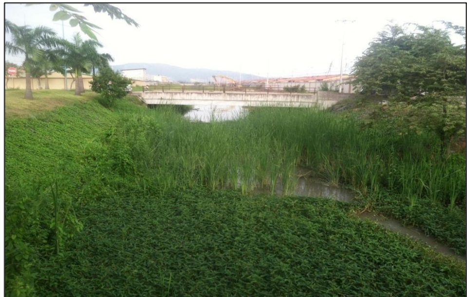
Foto 1.3.- Fotografía de un Canal divisorio entre etapas, La Joya Fuente: Autores, Junio 2015.
