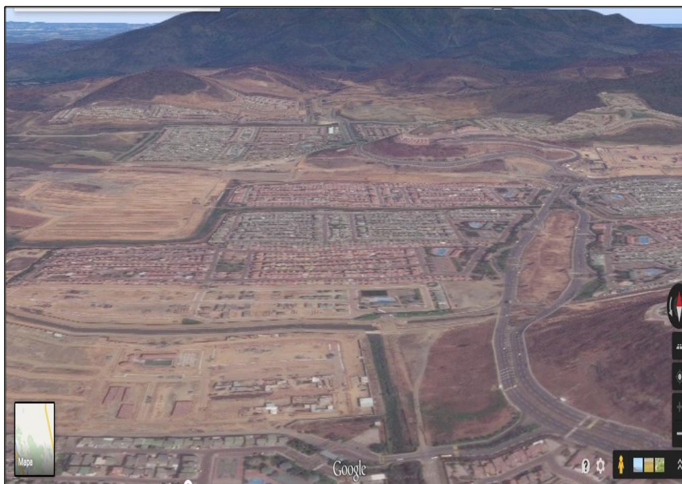
Imagen 3.- Vista de la segunda etapa de “La Joya”, el área más afectada. Fuente: Google earth, Junio 2015.
