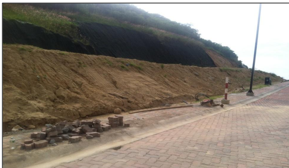
Foto 7.5.- Foto de un talud sin estabilizar donde el material erosionado fácilmente se desplazará hacia las cunetas. Fuente: Autores, Agosto 2015.
