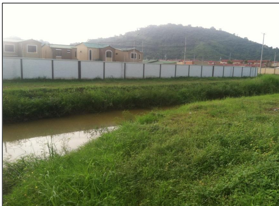
Foto 1.1.- Canales para la evacuación de aguas lluvia estancadas correspondiente a la segunda etapa de La Joya. Fuente: Autores, Junio 2015.
