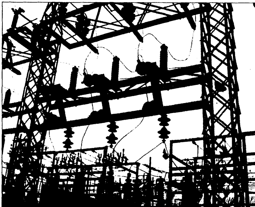
Fig. 4.2 Aisladores y Herrajes en patio de 69 KV
