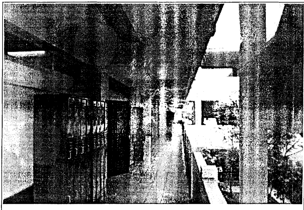
FOTO # 4 : VISTA DE PRIMER PISO DE AULAS DE COPOL
