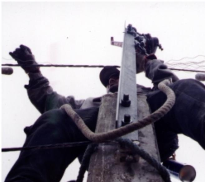
**Figura 11.10 Instalación del Blindaje en el H/G**
