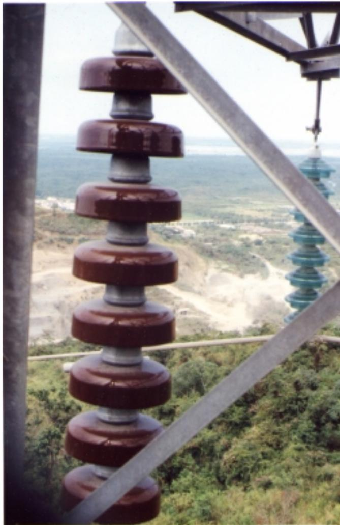
**Figura 6.1 Cadena de aisladores Tipo Antifog**
