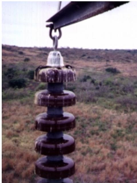
**Figura 11.5 Cadena de Aisladores de La Estructura # 222 de la L/T Pascuales Sta. Elena a 138 KV.**
