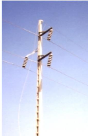
**Figura 12.1 H/G Afectado por la Contaminación por Salinidad
