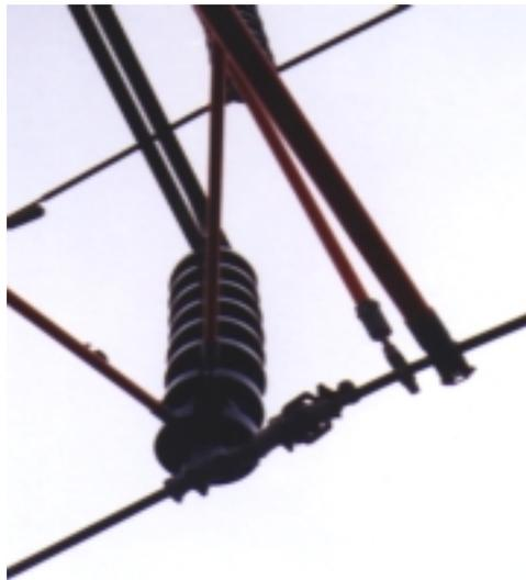
**Figura 11.19 Cambio de Posición de la cadena de aisladores**
