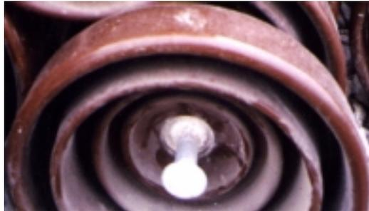
**Figura 5.11 Aislador de Suspensión con Problemas de corrosión**
