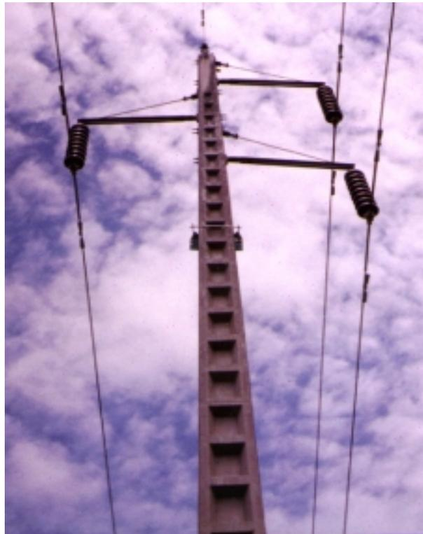
**Figura 4.6 Poste de Hormigón Vibrado de la L/T Pascuales – Santa Elena**
