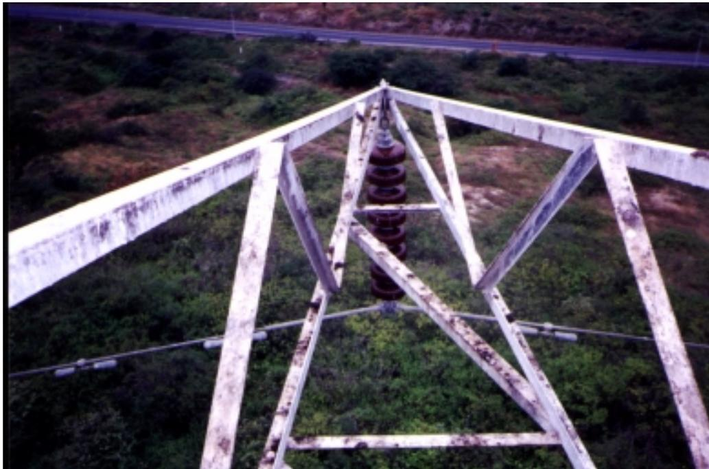
**Figura 4.2 Corrosión en la Cruceta de la Estructura Metálica Tipo Suspensión Pesada de la Línea Pascuales - Santa Elena a 138KV.**
