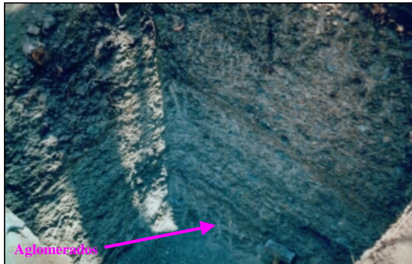
Fotografía 1. Calicata donde se aprecian aglomerados
