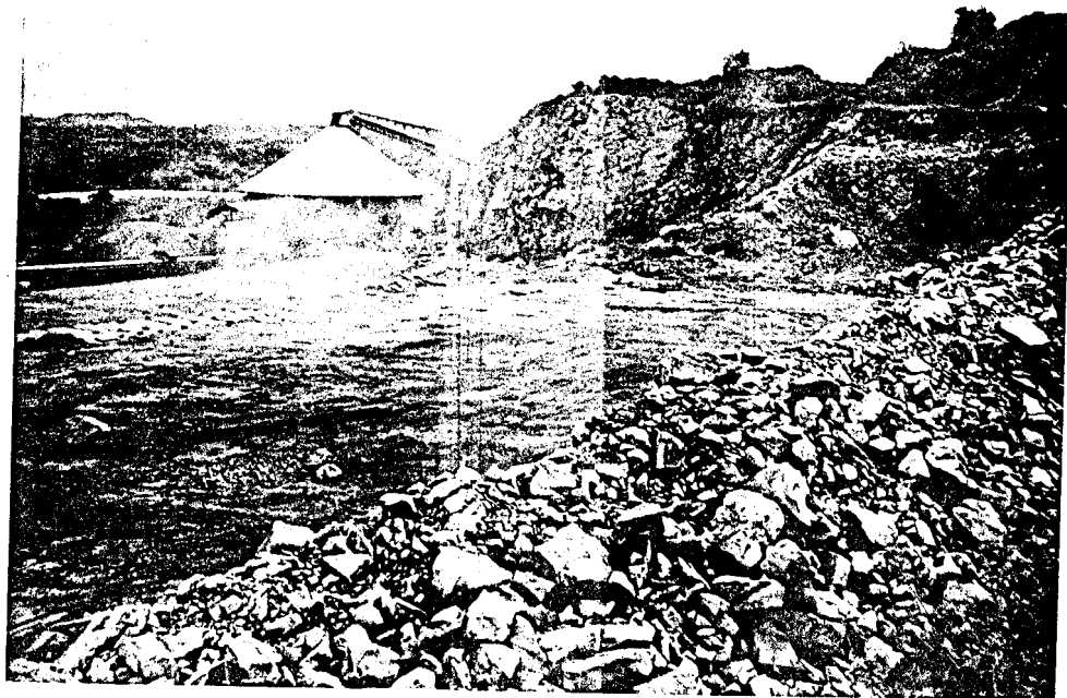
Foto # 23: AMBIENTE POLUIDO DEBIDO A LA DESCARGA DEL CLINQUER NO PULVERIZADO
