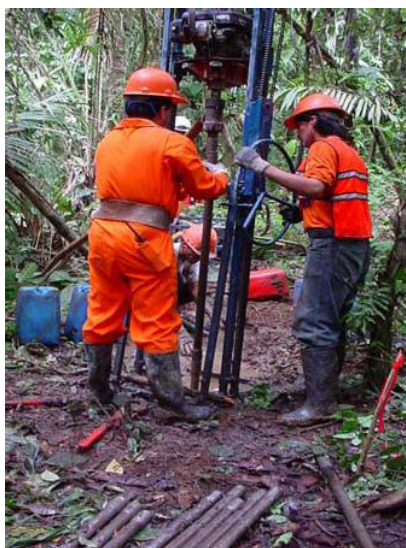
Figura 4.1.- Perforación con compresores de aire y tuberías en suelos secos
