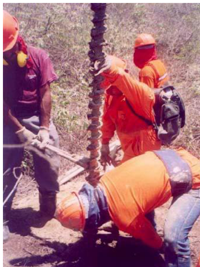
Figura 4.2.- Perforación con espirales en terrenos fangosos.
