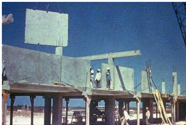
Fig. 1. Montaje de un Edificio Prefabricado
