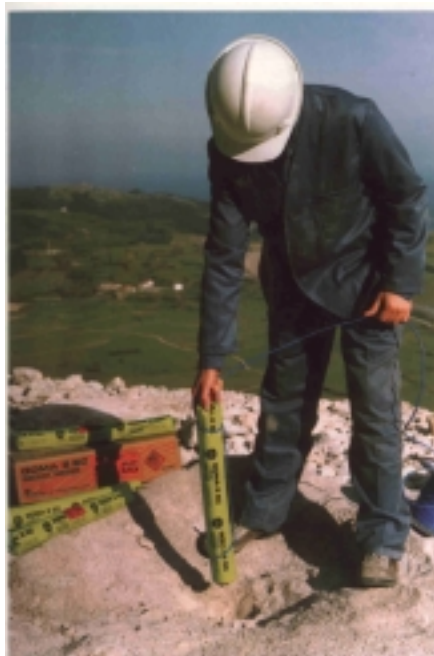
Figura 1. 1 Carga de fondo de un barreno con cartuchos de Goma 2-EC en mediano calibre y cordón detonante de 12 g. (Cortesía de UEE, S.A.)
