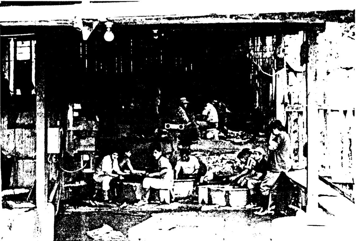
Fotografía 1.10 Bateado del concentrado del canalón
