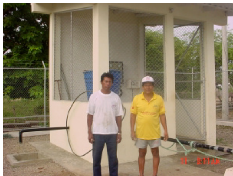
Foto 7. Junta de agua Potable Unión y Progreso en Pechiche.
