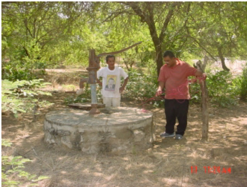
Foto 8. Pozo con bomba manual ubicado en Atahualpa.
