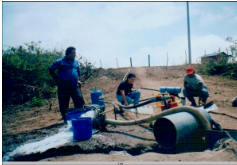
Foto 17. Prueba de bombeo realizada en el Proyecto de la ESPOL en Pechiche.
