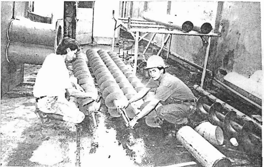
Comprobación de medidas en los ejes del sinfin
