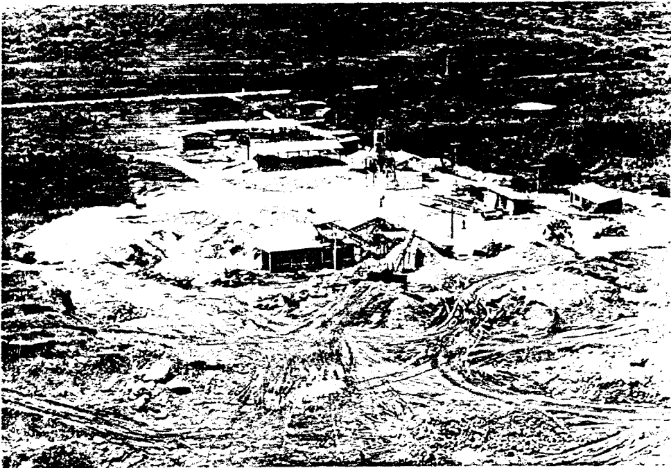
Foto 4: Vista general de la Planta de Trituración.
