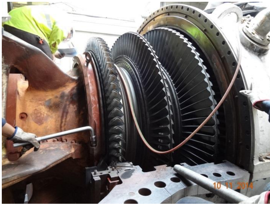
Figura 16: Mantenimiento de Ruta de Gases Calientes
