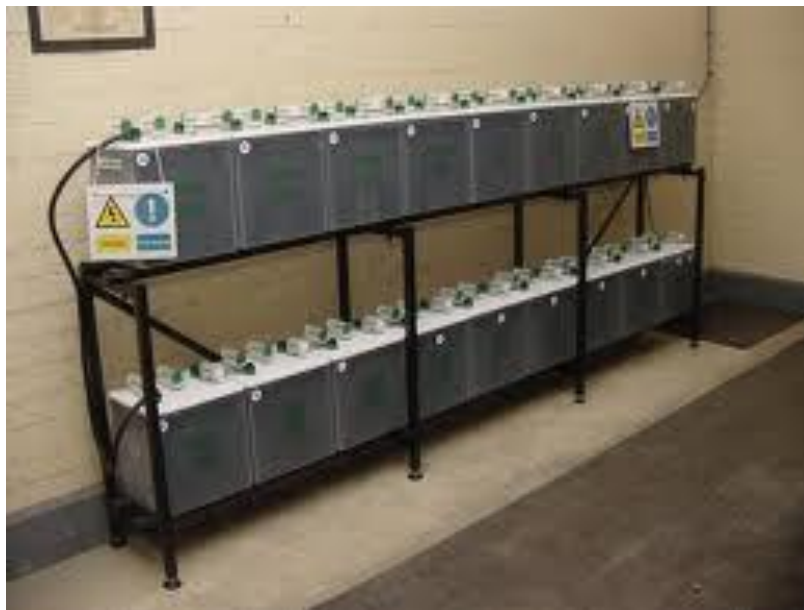
FIGURA 1.5 BANCOS DE BATERÍAS
