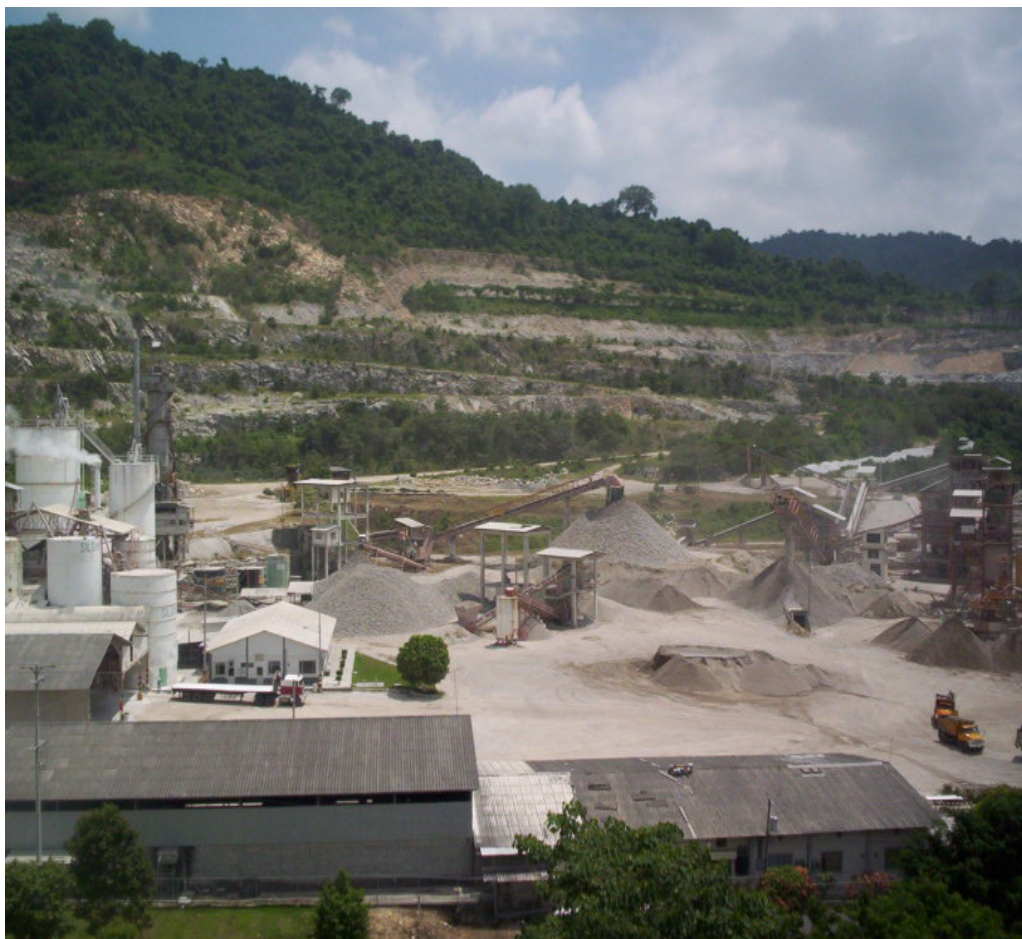
Figura 1.2. Vista de la Planta Huayco de Calizas Huayco S.A.
