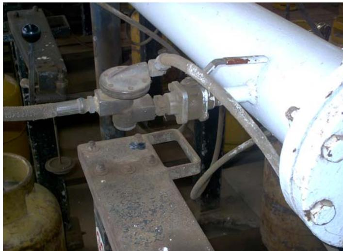
**FIGURA 1.10** DISPOSITIVO PARA CORTE DE FLUJO DE GLP
