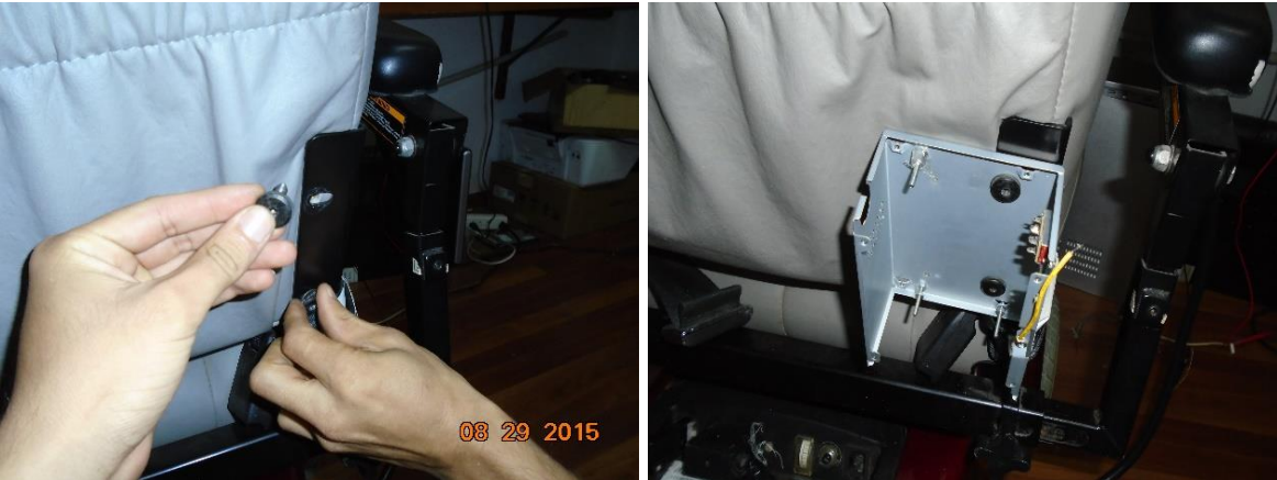
Figura 3-15. Instalación de caja metálica como tierra del circuito
