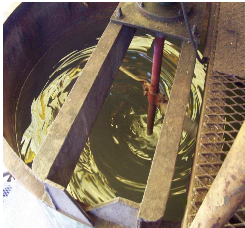
Figura 1.13. Preparación del floculante
