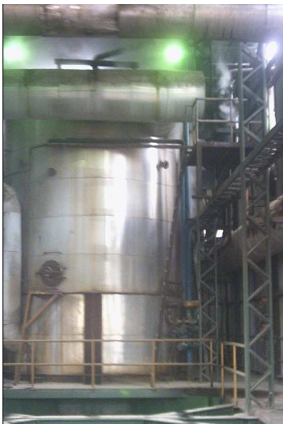
Figura 1.20. Pre-evaporador
