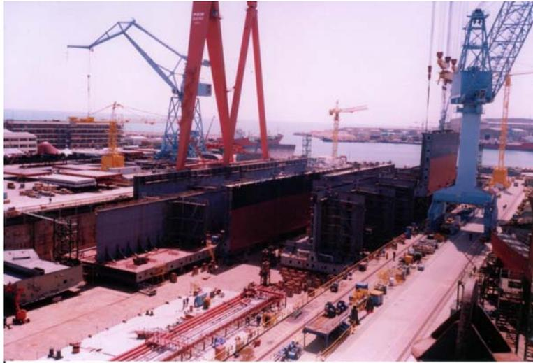
**Figura 1.4. Ensamblaje de un Buque en Etapa de Dique**
