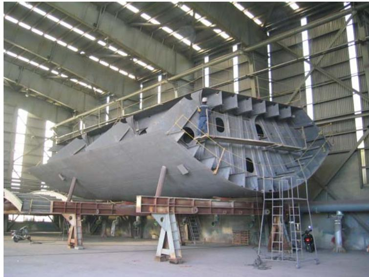
**Figura 1.3. Preparación Superficial de un Bloque.**
