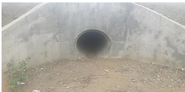
*Figura 1: Alcantarilla en la carretera para drenaje de aguas lluvias*
