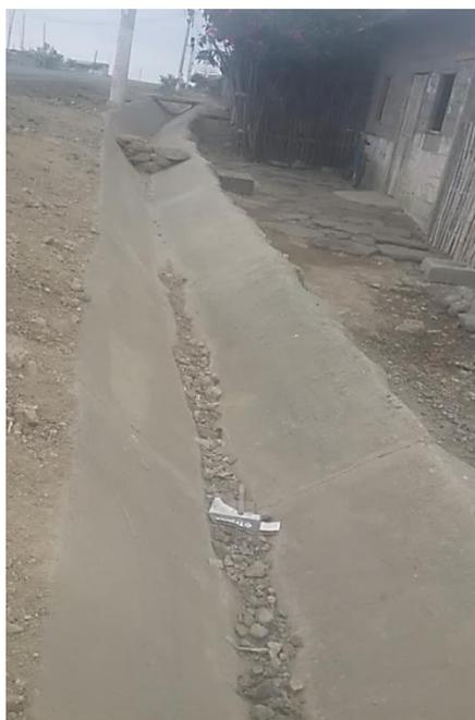
*Figura 2: Canal de conducción de aguas lluvias hacia alcantarillado*
