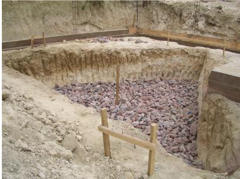
FIGURA 2.11 MEJORAMIENTO DEL SUELO
