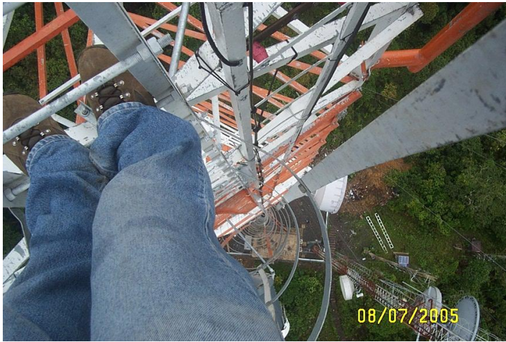
FIGURA 2.2 ANILLOS DE SEGURIDAD
