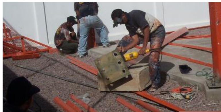
FIGURA 2.16 COLOCACIÓN DE PATA DE TORRE
