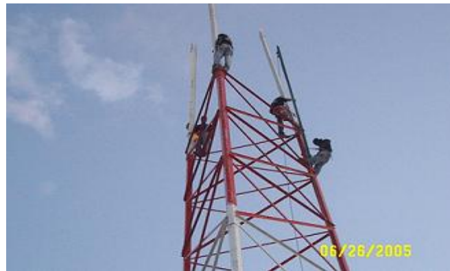
FIGURA 2.15 MONTAJE DE TORRE
