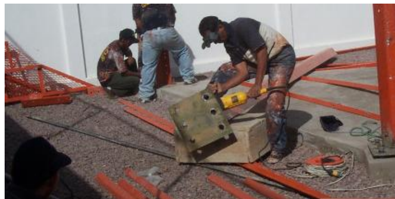
FIGURA 2.16 COLOCACIÓN DE PATA DE TORRE
