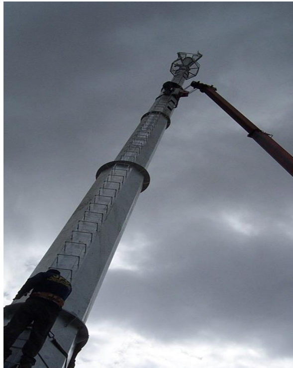
FIGURA 1.7 TORRE TIPO MONOPOLO
