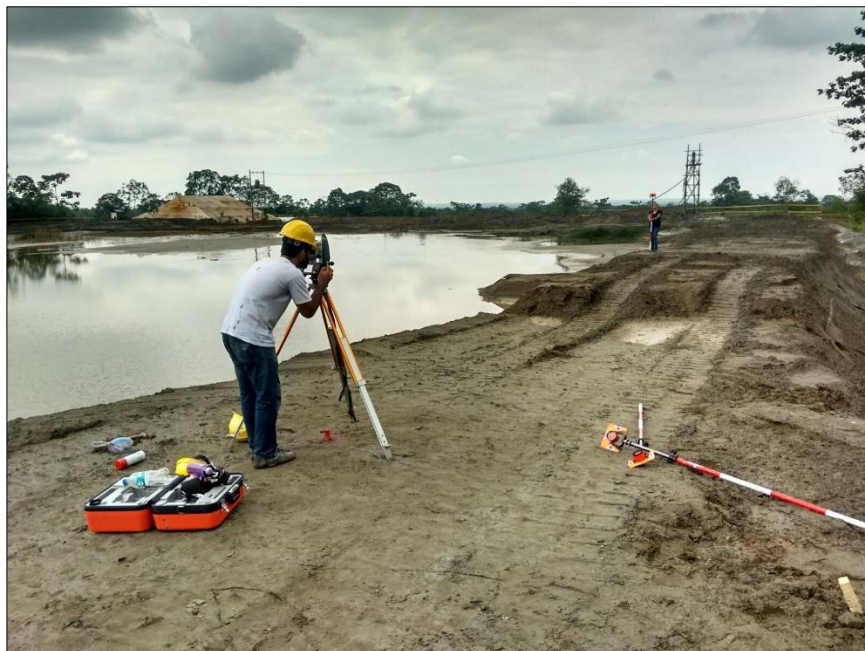
Figura 9. Topografía de la relavera perteneciente a la planta de procesamiento La López
