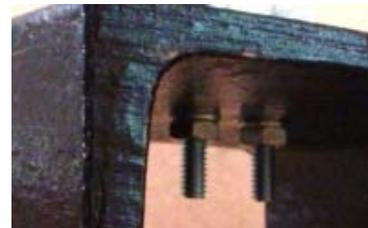
**Figura 4.9 Pernos, arandelas y tuercas de sujeción.**
