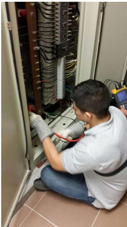
Figura 1: Instalación del equipo de medición en las celdas del cuarto eléctrico del edificio
