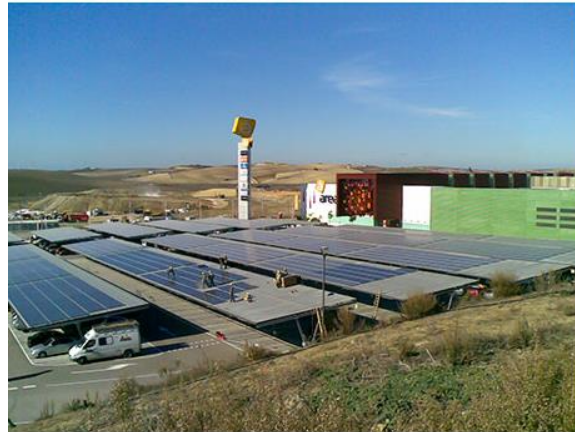
Figura 2.5: Instalación de un sistema fotovoltaico en estructura techada [18]
