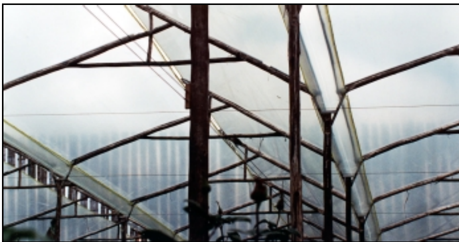
FOTO 8: CUBIERTA DE INVERNADERO CON ESTRUCTURA DE MADERA
