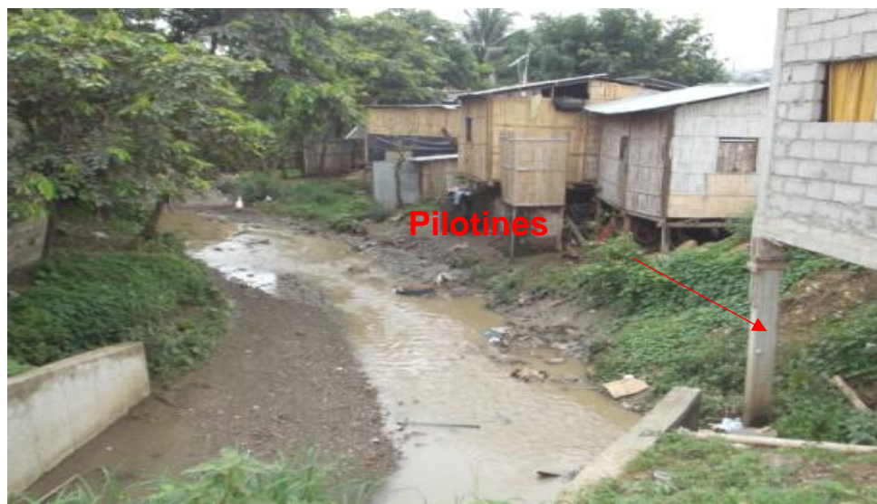
Figura 2.1 Casas de caña al pie del canal Fuente: Google Earth, 2016
