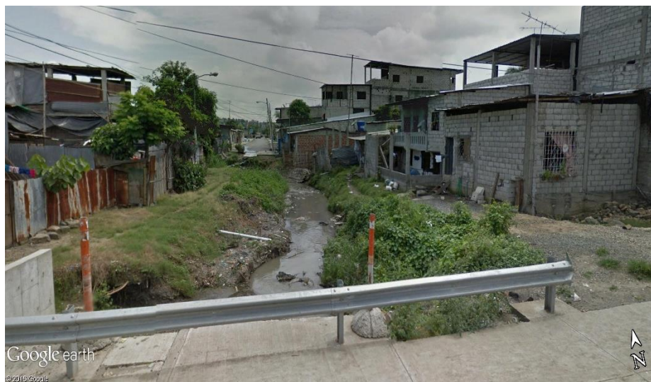
Figura 4. 22 Construcciones de viviendas invadiendo el canal Fuente: Autores, 2016
