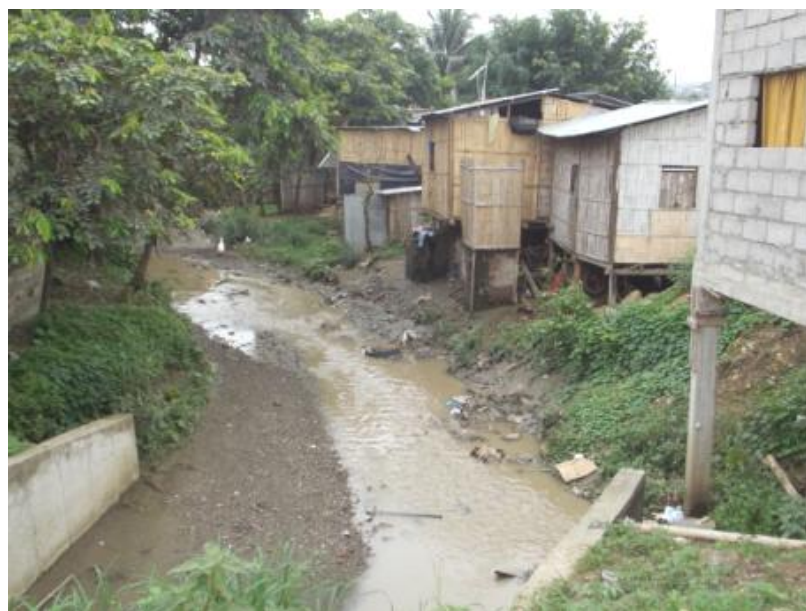
Figura 4.1 Casas construidas cerca del cauce del canal Fuente: Google Earth, 2016
