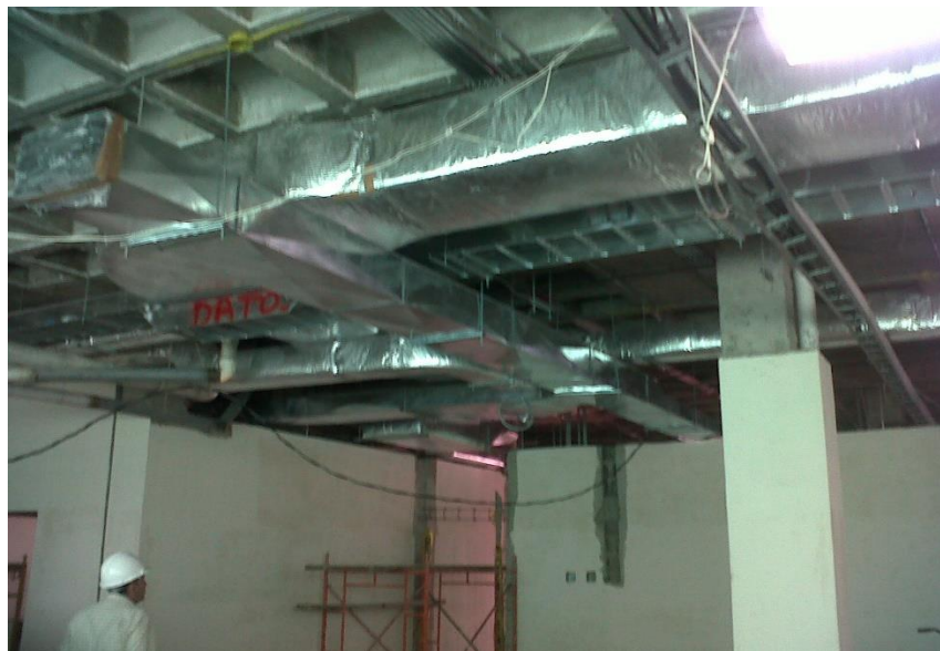
Figura 13: Montaje de ductos
