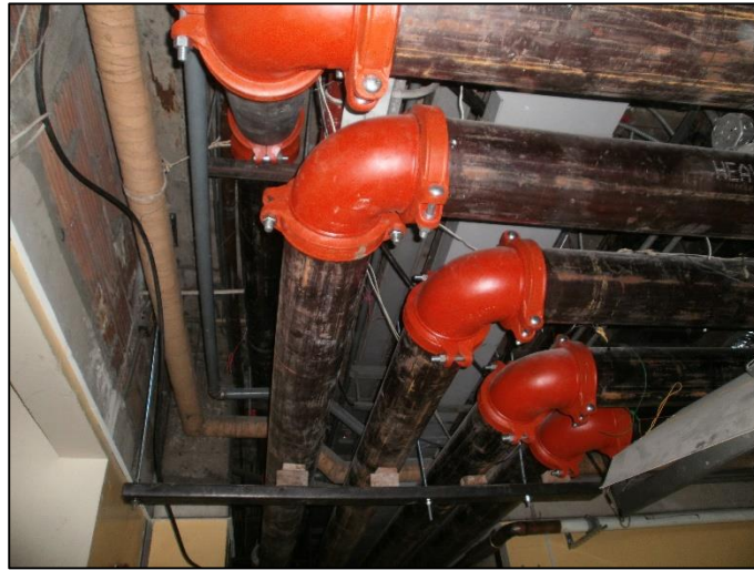
Figura 12: Montaje de tuberías de agua helada
