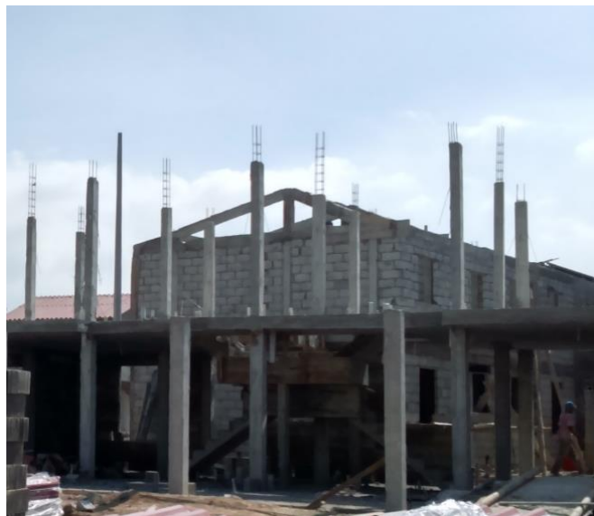
Figura 1.3. Casas de Villa España 2 en Construcción Fuente: Tomada por los autores
