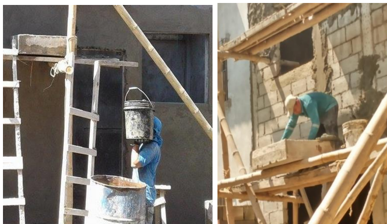
Figura 4.26. Trabajo Contributorio Enlucido Fuente: Tomada por los autores
