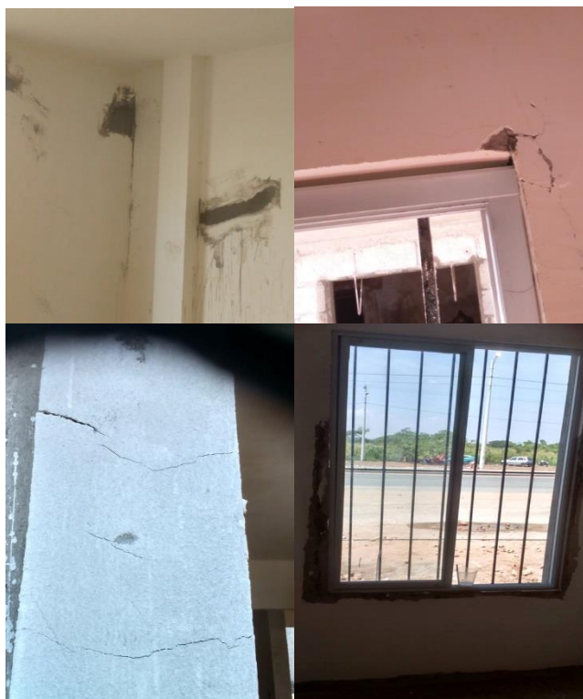
Figura 4.10. Reparaciones en la obra Villa España Fuente: Tomada por los autores
