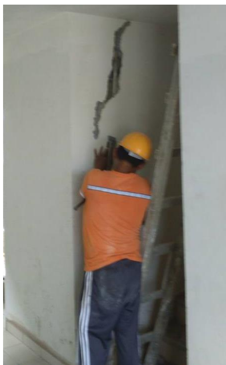
Figura 4.8. Colocación de instalaciones eléctricas olvidadas Fuente: Tomada por los autores
