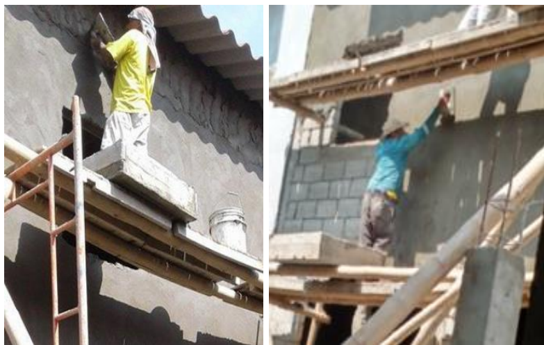
Figura 4.25. Trabajo Productivo Enlucido Fuente: Tomada por los autores
