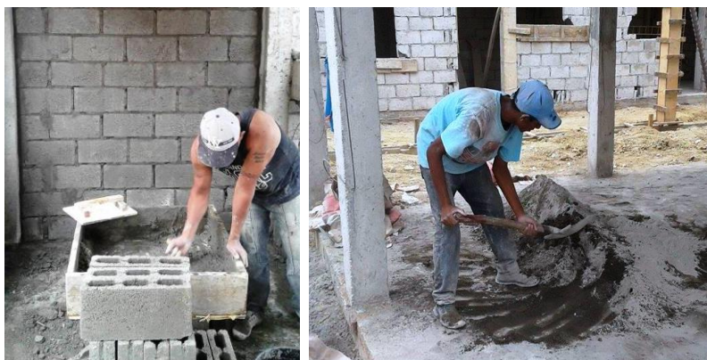
Figura 4.19 Trabajo Contributorio Mampostería
