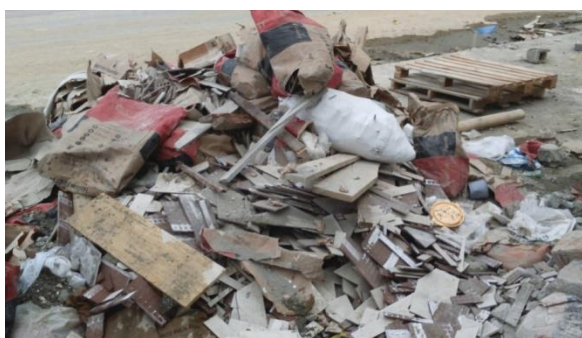
Figura 4.5. No reutilización de piezas de cerámica Fuente: Tomada por los autores
