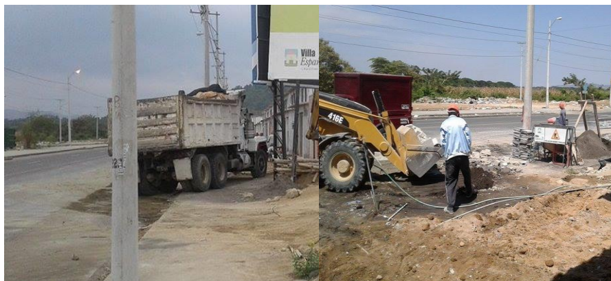
Figura 4.13. Limpieza de la obra con maquinaria Fuente: Tomada por los autores
