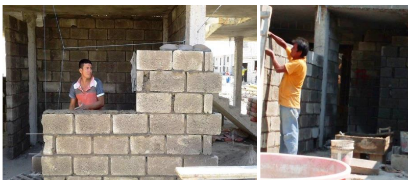
Figura 4.18 Trabajo Productivo Mampostería
