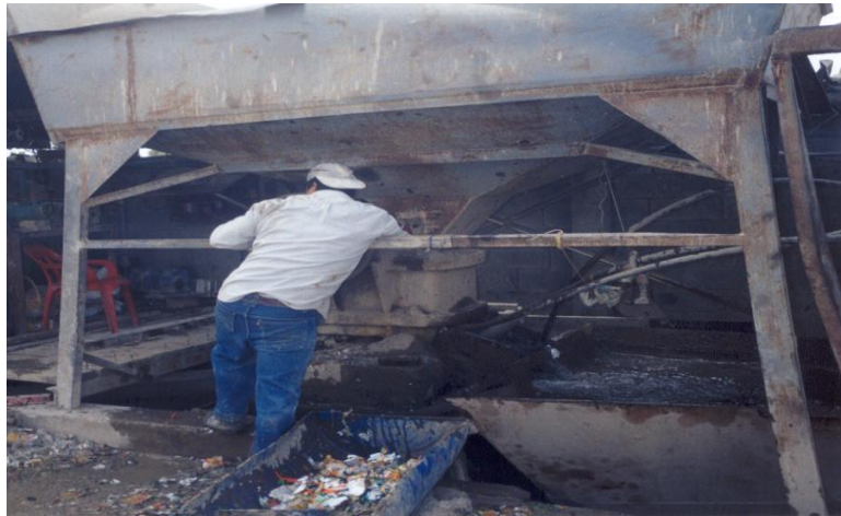
Fotografía 2.7. Tolva de recepción del vidrio
