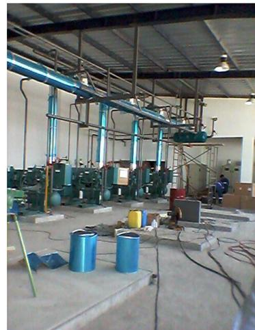
**Figura 19. Fotos de la instalación frigorífica en el área del cuarto de máquinas**
