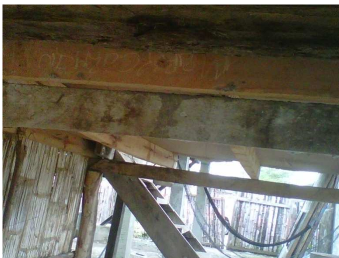
Ilustración 35 Cuartones deteriorados
