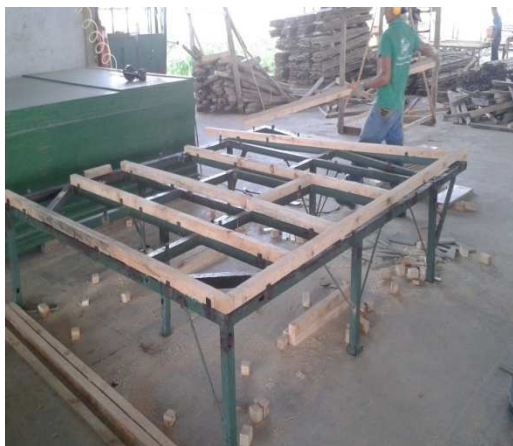
Ilustración 1 Formaleta para paneles
