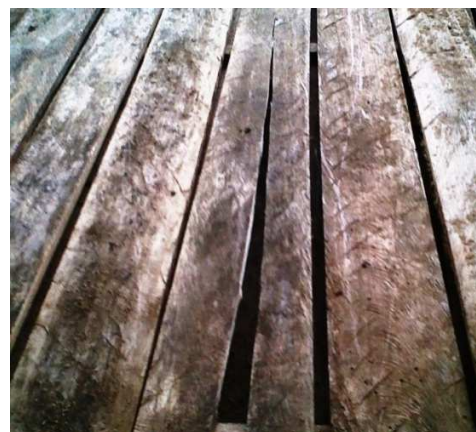
Ilustración 32 Tablas deterioradas 2
