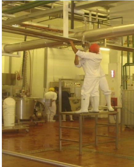
Gráfico 3.8. Cambio de dirección de tuberías.
