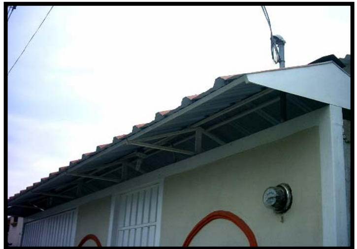
Estructura Metálica para techo
