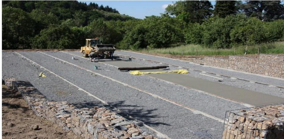
**Figura 5.2** Instalación de Pavimento Concreto Permeable
