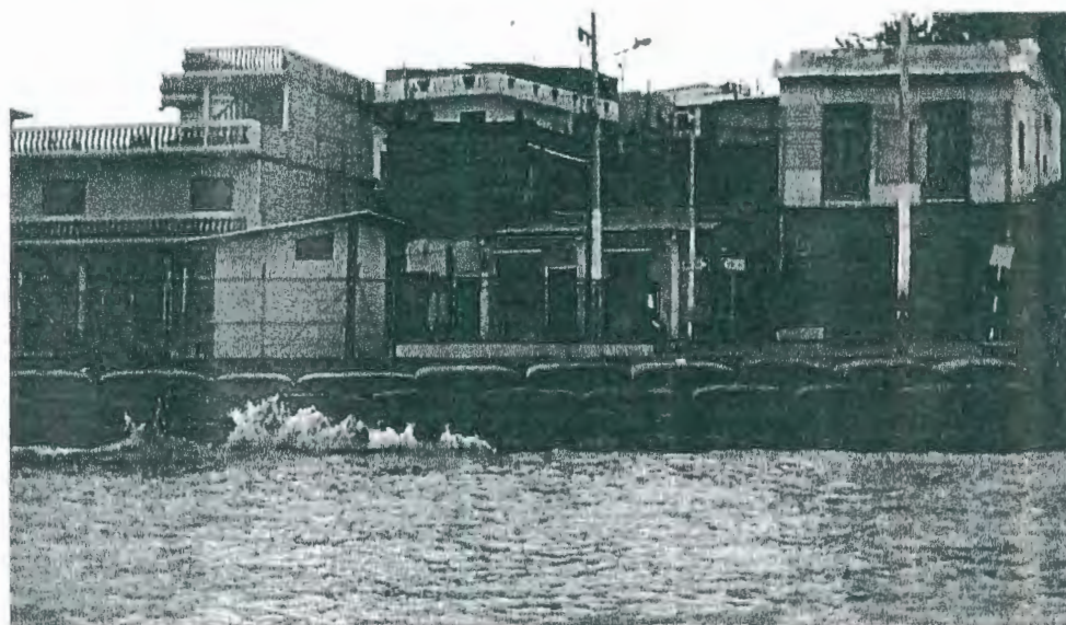
Fig. 15 Vista área de embarque y desembarque en Posorja en marea alta. Fuente: Trabajo de campo de la tesis
