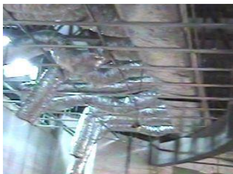
Figura 3.2c: Montaje de ductos flexibles.
