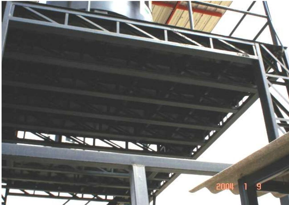
**FIGURA 2.4 VIGAS SOPORTES DE TORRE DE CALIBRACIÓN.**
